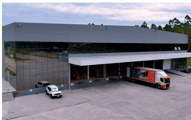
Centro de Distribuição - Paulo Lopes/SC
