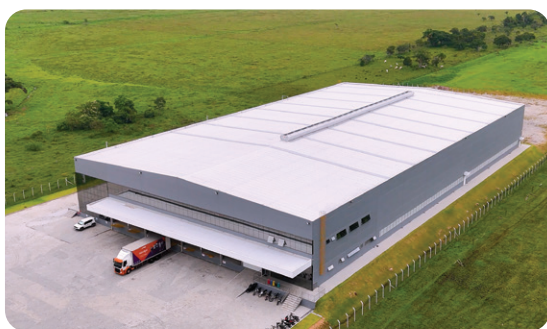
Centro de Distribuição - Paulo Lopes/SC
