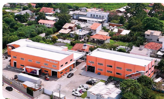
Escritório Administrativo e Fábrica - Garopaba/SC
