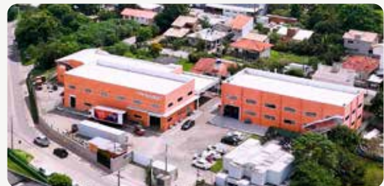
Escritório Administrativo e Fábrica - Garopaba/SC.
