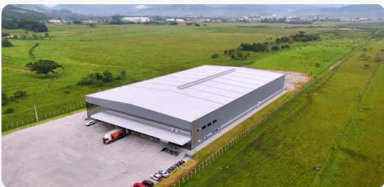
Centro de Distribuição - Paulo Lopes/SC.
