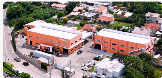
Escritório Administrativo e Fábrica - Garopaba/SC.
