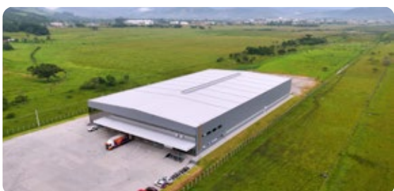
Centro de Distribuição - Paulo Lopes/SC.
