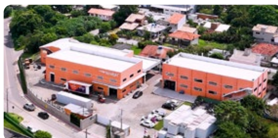
Escritório Administrativo e Fábrica - Garopaba/SC.
