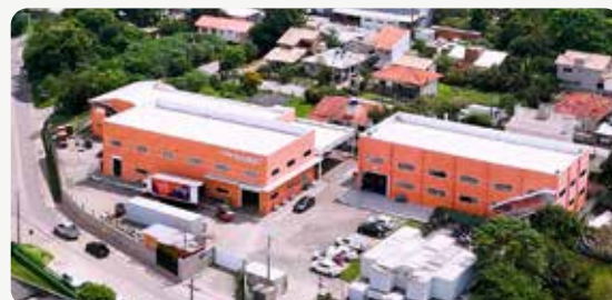
Escritório Administrativo e Fábrica - Garopaba/SC.
