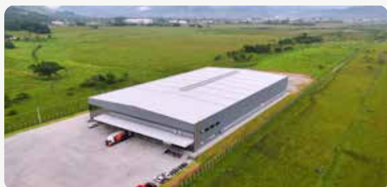
Centro de Distribuição - Paulo Lopes/SC.
